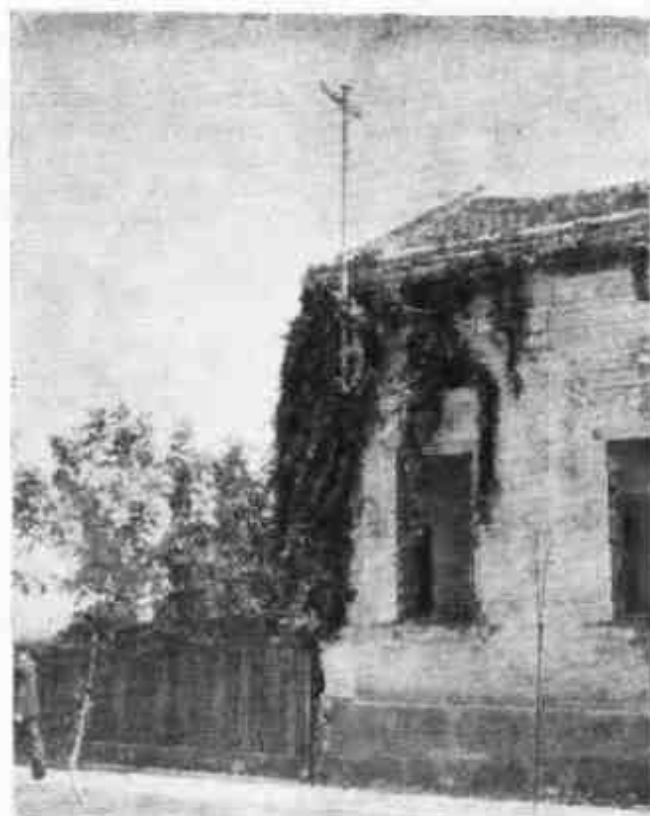
Рис. 2. Бесстолбовая проводка проводов питания фонарей, г. Ужгород.
