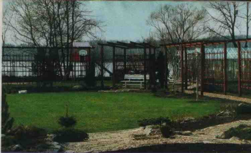
Начало работ. Установка перголы
