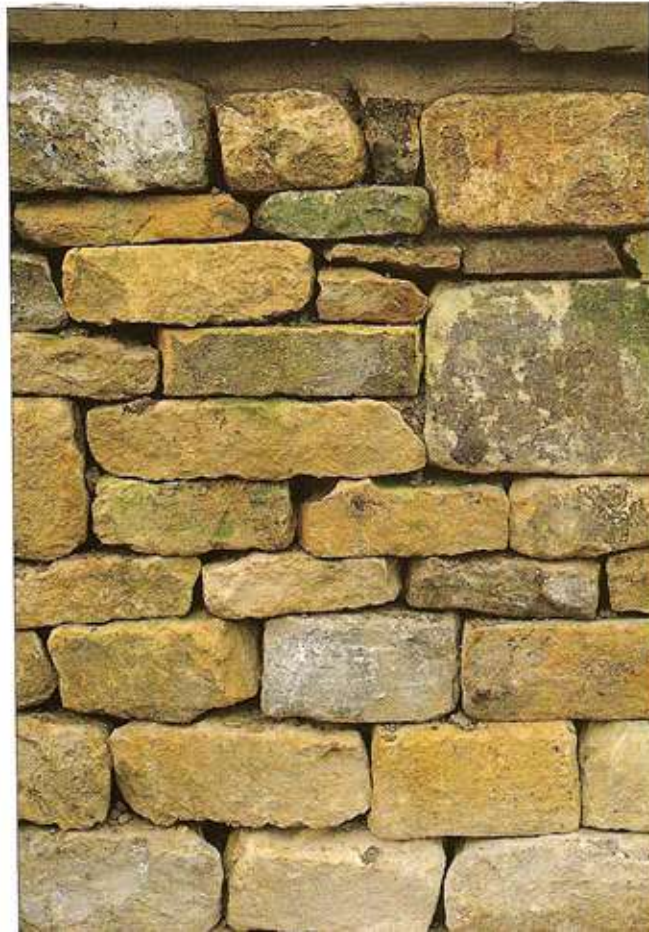
Стена, выложенная ровными рядами из сухого песчаника
