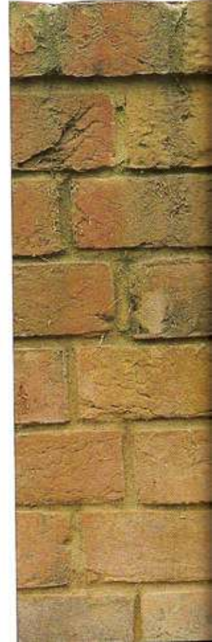
Кирпичная стена, выложенная двусторонней фламандской кладкой
