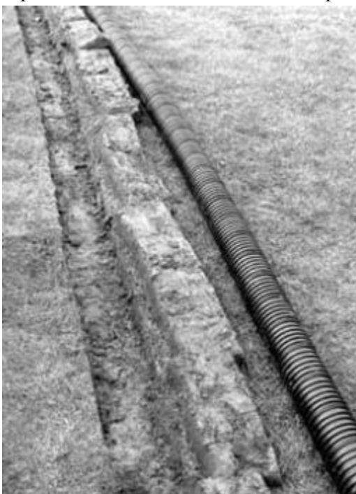
Рис. 3.3. Дренажная труба из пластика
