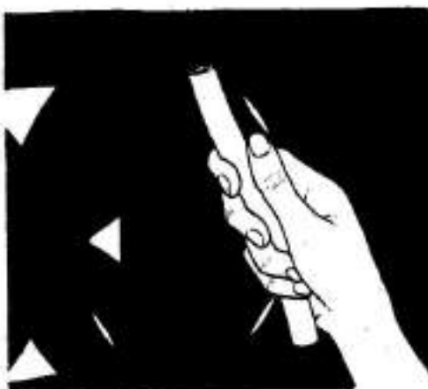
7 Аккуратно обработайте швы, проведя вдоль затвердевающего раствора куском водопроводного шланга, чтобы получить плавный закругленный профиль.
