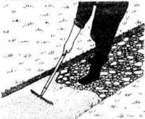
4 Закройте поверхность плотного материала слоем песка толщиной 50 мм и разровняйте его граблями, чтобы заполнить пустоты, образовавшиеся в слое плотного материала.
