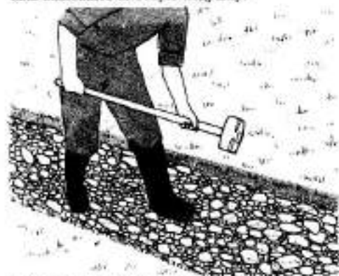
3 Уложите слой плотного материала толщиной около 75 мм и хорошо утрамбуйте его с помощью кувалды или садового катка.
