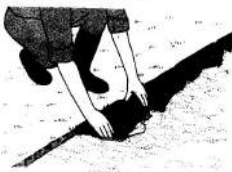
1 Уложите плитки с прямым краем на мазки строительного раствора по бокам дорожки.
