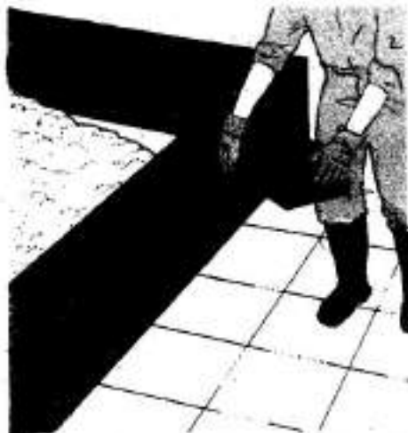
2 Используйте несколько рядов шпал, чтобы получить необходимую вам высоту цветника. При укладке вертикальные стыки делайте ступенчатыми — это обеспечит прочную связь между шпалами.
