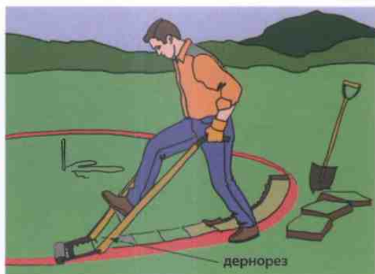
2. Внутри круга удалите весь дерн. Если у вас нет специального дернореза, используйте обычную штыковую лопату. Колышек оставьте на месте.
