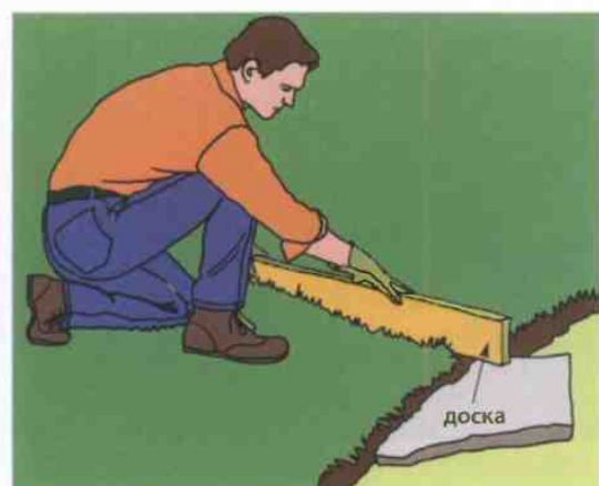
3. Снимите слой грунта внутри круга так, чтобы поверхность плиты была примерно на 3 см ниже уровня дерна. Для измерения зазора полезно воспользоваться доской.
